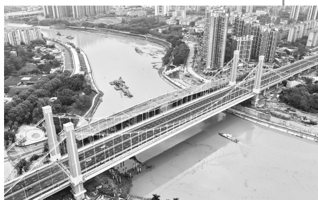
▲平陆运河27座跨运河桥梁全部建成 这是4月28日拍摄的建成通车的平陆运河子材大桥(无人机照片)。4月28日,平陆运河关键跨河通道子材大桥正式通车,标志着平陆运河规划的27座跨运河桥梁全部建成。(新华)
