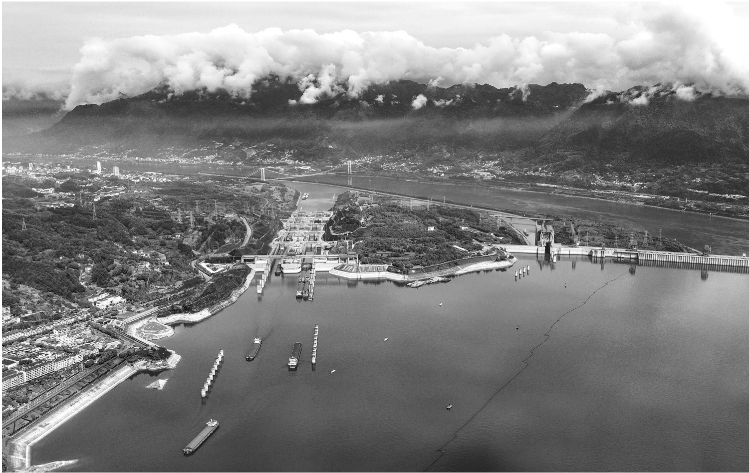
▲ 三峡水库为长江中下游补水超100亿立方米 5月13日,在湖北宜昌,船舶有序通过三峡双线五级船闸(无人照照片)。据中国三峡集团消息,自2025年11月21日启动枯水期补水调度以来,截至5月12日,三峡水库已累计为长江中下游补水超100亿立方米,为长江中下游沿线民生供水、农业生产、航运畅通及生态保护提供了坚实保障。(新华)
