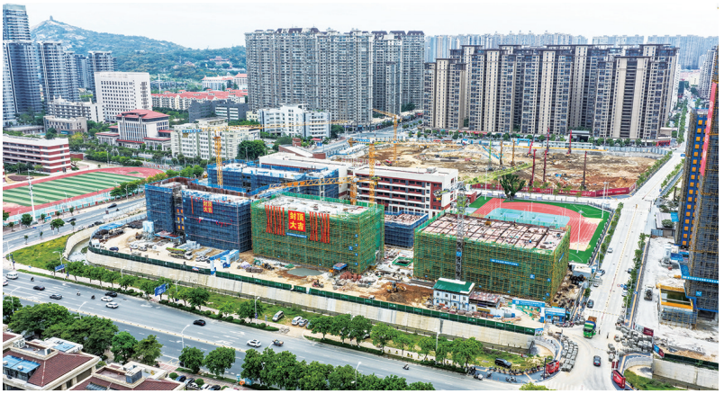
石狮一中宝盖校区二期工程项目现场塔吊林立、机械轰鸣，多栋建筑主体施工正有序推进，其中，6#教学实验楼和7#食堂综合楼主体结构已封顶，部分楼栋也进入封顶冲刺阶段。据悉，项目主体建筑将于8月初完工，8月中旬完成室外工程等配套项目建设，整体交付学校使用。(记者 颜华杰)
