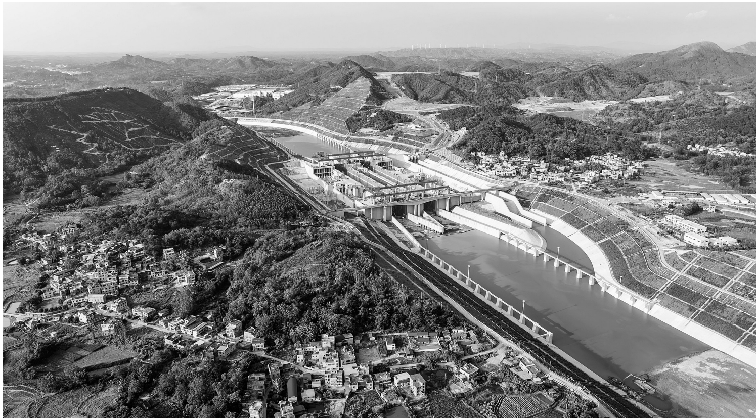
6月3日拍摄的广西平陆运河马道枢纽充水现场(无人机照片)
