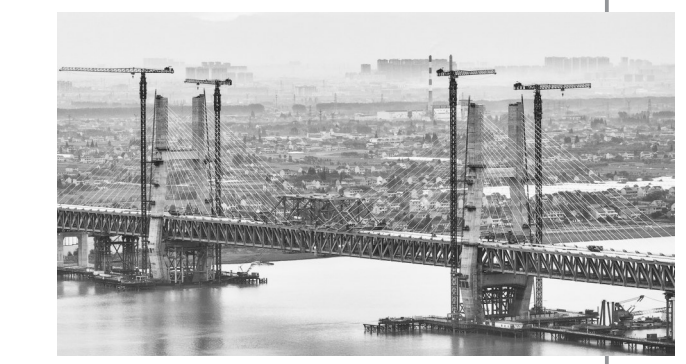
崇启公铁长江大桥主桥成功合龙 6月9日,由长江沿岸铁路集团江苏公司建设、上海国铁建管公司管理、中铁大桥局施工的崇启公铁长江大桥主桥成功合龙。崇启公铁长江大桥是我国“八纵八横”高速铁路网沿江通道主干线路——沪渝蓉沿江高铁的关键控制性工程,全长4.09公里,主跨400米,横跨长江入海口北支航道。大桥采用双层布置,上层为设计时速100公里的双向六车道一级公路,下层为设计时速350公里的双线高速铁路和时速250公里的双线城际铁路。崇启公铁长江大桥通车后,上海至启东铁路通行时间将从目前的2个半小时缩短至半小时,对完善长江经济带综合立体交通走廊、服务长三角一体化高质量发展等具有重大意义。(新华)
