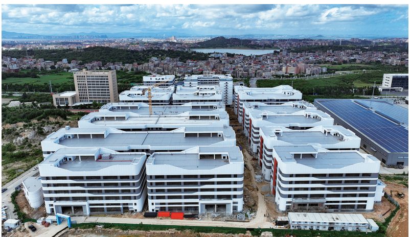
近日,腾讯云·中重数字孪生产业园所有主体建筑的手脚架已经全部拆除,露出全貌。作为坐落于蚶江镇的省级重点项目,目前正稳步推进配套装修、设备安装等后续施工工作。该项目总投资30亿元,总建筑面积约22万平方米,规划建设4000P智算中心,打造区域标杆算力集群,集聚人工智能、云计算、数字孪生等科创产业,构建数字经济产业生态。(记者 李荣鑫)
