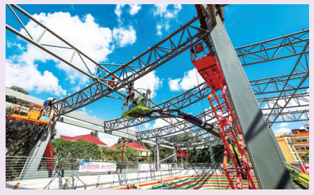
日前,在蚶江镇厝仔村“厝锦体育中心提升工程”一期建设现场,施工人员正加紧钢结构安装、焊接作业,7月底项目主体工程可基本完工。(记者 兰良增 颜华杰)
